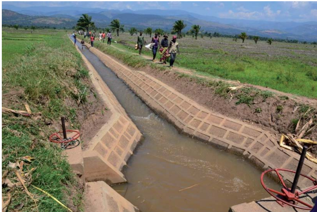
Canal tête morte pour l'irrigation du périmètre de Nyamabere
